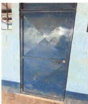
Foto 3: Sustitucion de puerta de metal.
