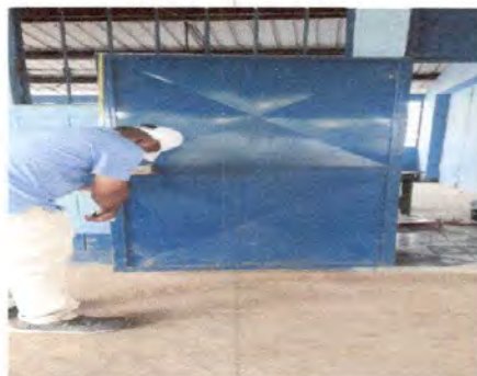
Foto 2: Sustitucion de puerta de metal.
