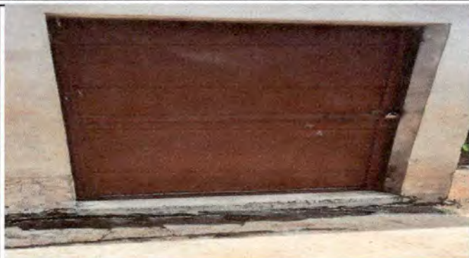
Foto1: Sustitucion de puerta de metal
