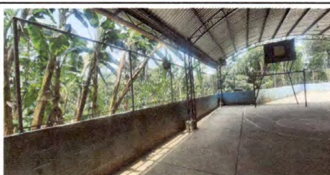
Foto 11: sustitucion de barandas de metal
