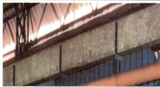
Foto 8: Sustitucion de soporte o pescante de metal para canal.
