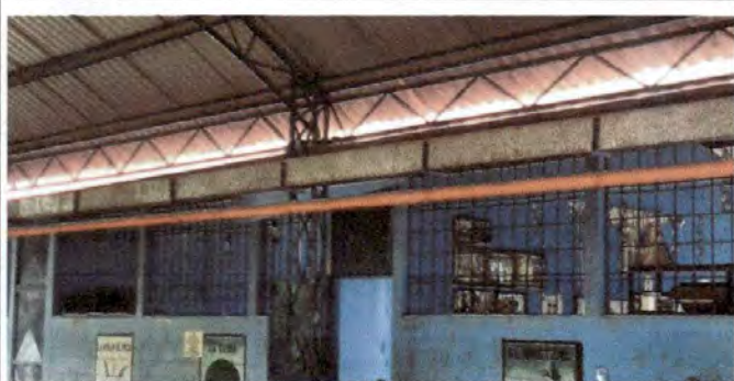
Foto 7: reparacion de bajada pluvial tubo pvc 3"
