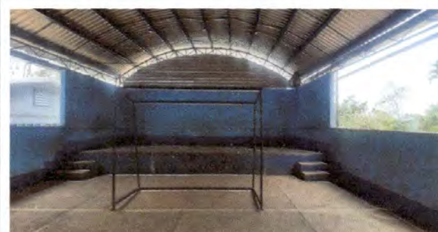
Foto 9: pintura de muros exteriores e interiores
