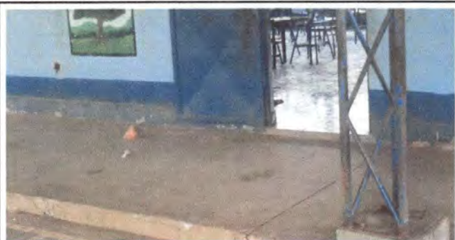
Foto 5: sustitucion de piso ceramico
