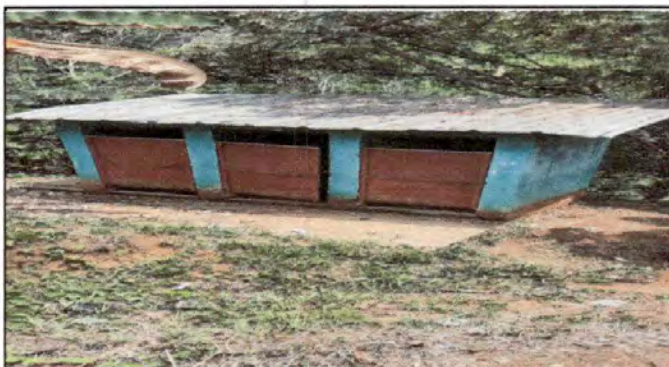
Foto 4: sustitucion de puertas en servicios sanitarios
