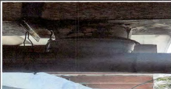
Foto 6: sustitucion de canal de metal
