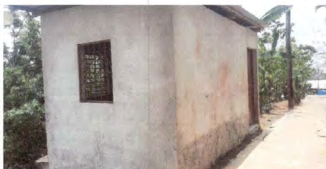
Foto 10: pintura de muros exteriores e interiores
